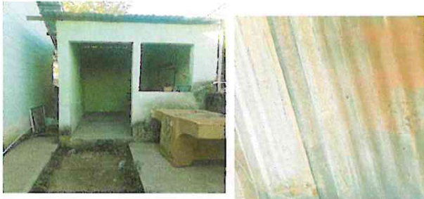
Foto 1: Sustitución de lamina (canalada o duralita) por lamina troquelada en la cocina
