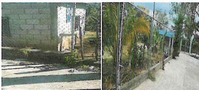
Foto 5: Reparación de muro perimetral de block con (soleras intermedias y columnas) en el patio frente a las aulas y la calle.
