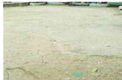
Foto 4: Reparación de losa de patio (con espesor de 8 cm. O 10 cm.) en el patio frente a la cocina
