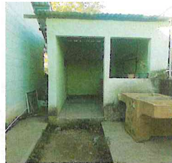
Foto 2: Implementación de ventana PVC y mosquitero en la cocina, implementación de puertas de metal en la cocina. Sustitución de piso de concreto por piso cerámico en la cocina.
